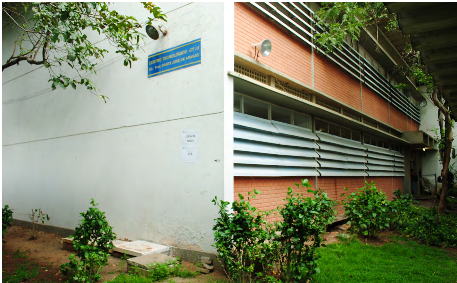
FIGURA 22: Mais uma entrada escondida que não se conecta diretamente com o eixo principal, o CT já faz uso de placas nas laterais, mas não em todos os prédios.
