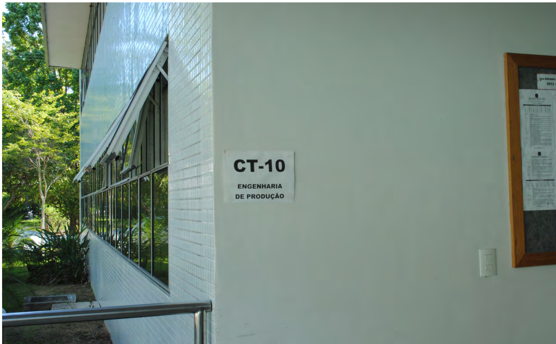
FIGURA 12: Placa improvisada que identifica o CT 10, na entrada do prédio.
