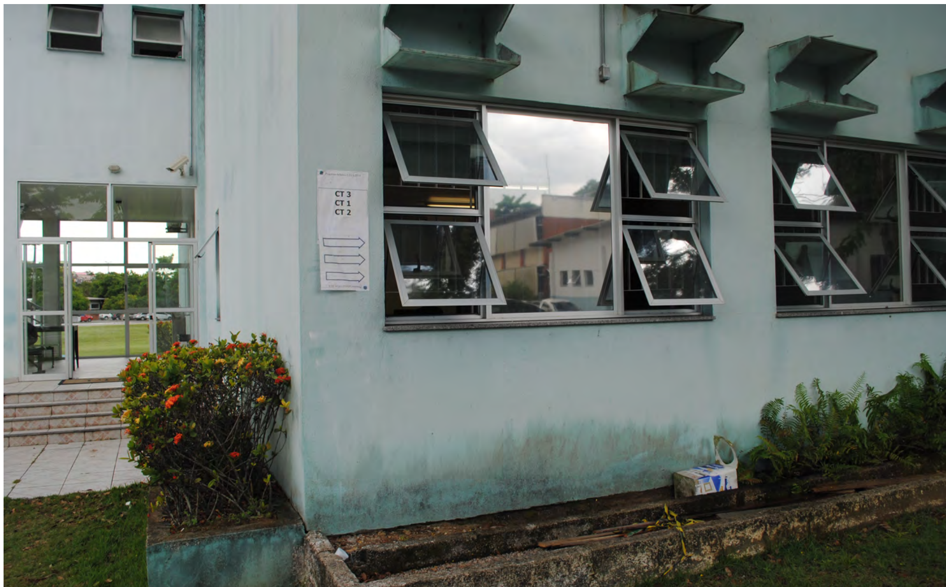
FIGURA 13: Placa direcionadora improvisada para sinalizar os locais de prova ao visitantes.
